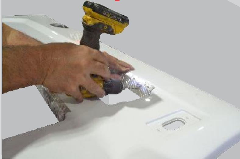
Décimo oitava passo: Instalar os itens 2.9 e 2.10, utilizando as próprias peças como gabarito de furação após fazer isso fixa-la no local, utilizando:
