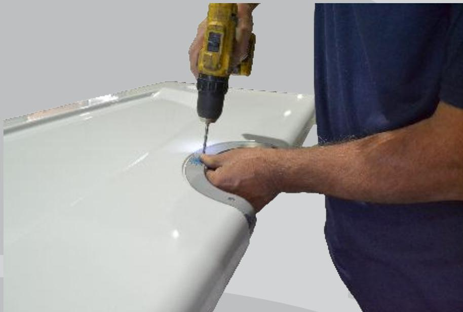
Décimo sétimo passo: Instalar o item 2.1 utilizando a própria peça como gabarito de furação após fazer isso fixa-la no local, utilizando:
